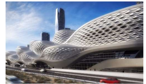
RIYADH METRO Riyadh - KSA
